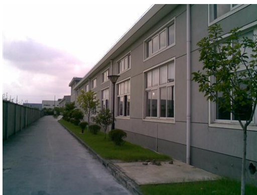
项目厂房外景现状
